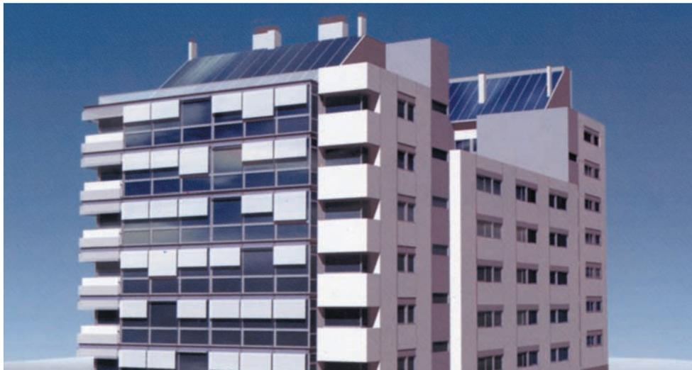
*Foto 9 Colectores solares integrados en cubierta.*
