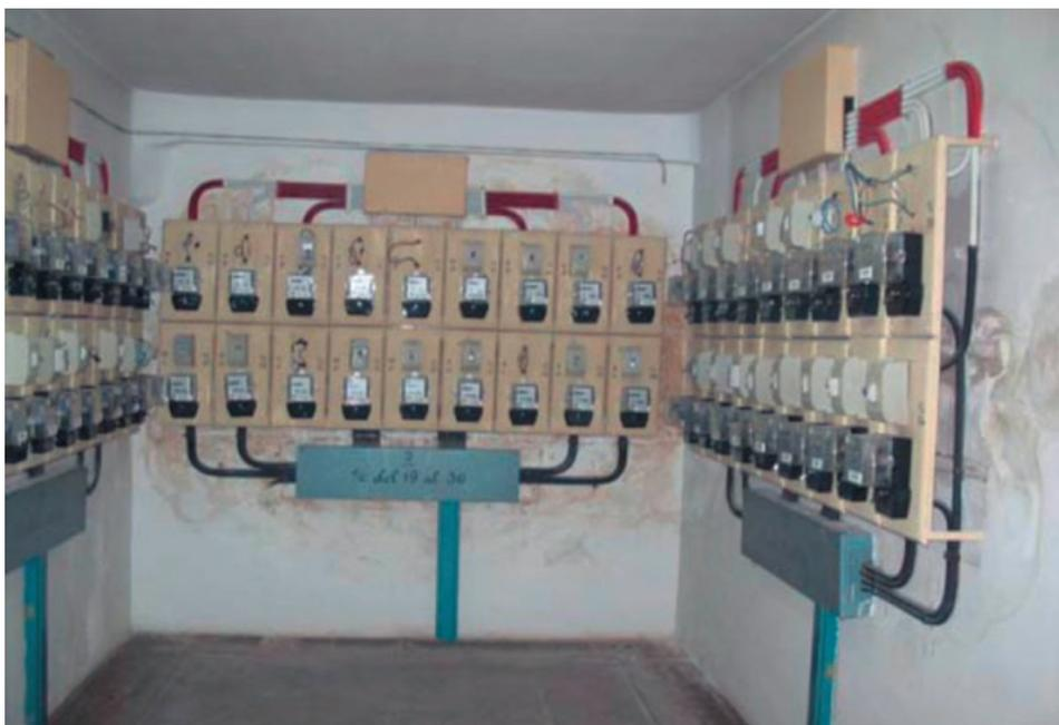
**Figura 4.** Centralización de contadores.
