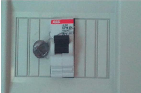
**Figura 10.** Interruptor de Control de Potencia (ICP) de 30 A.
