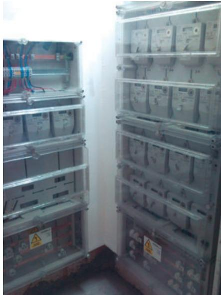
**Figura 8.** Detalle de centralización de contadores.
