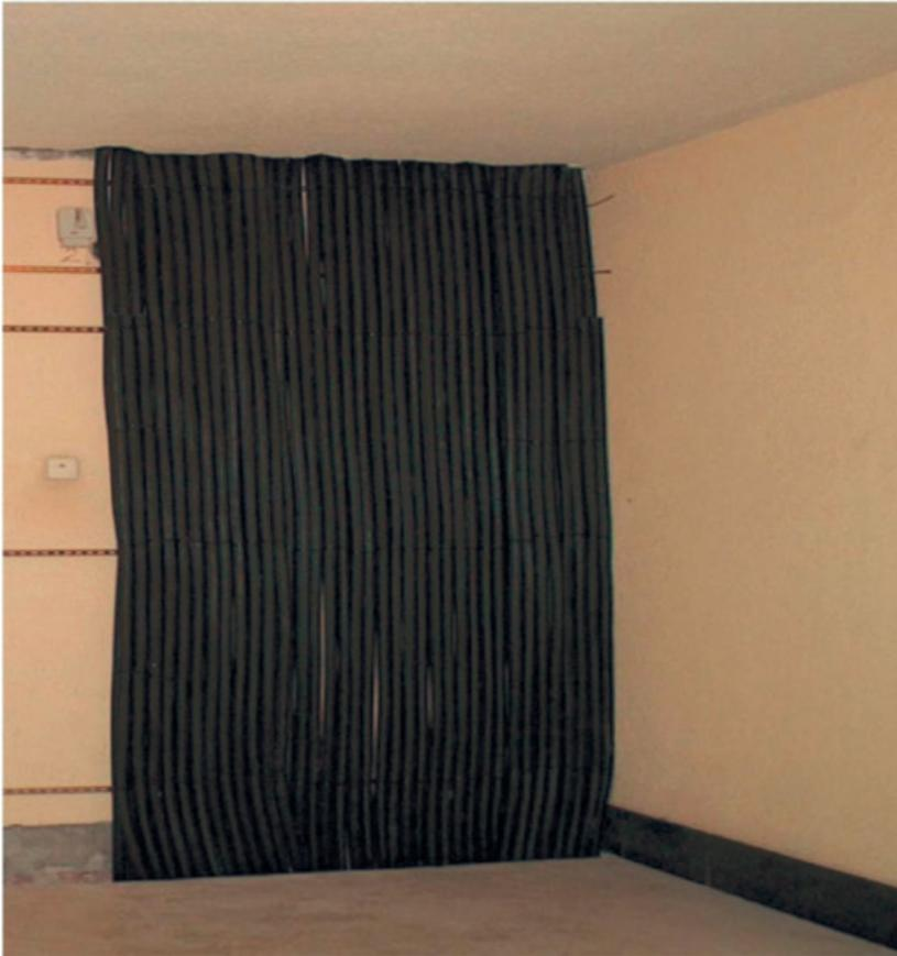
**Figura 9.** Canalizaciones de derivaciones individuales.
