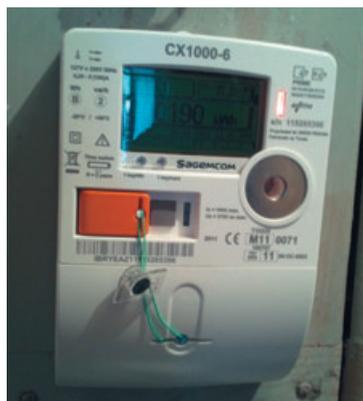
**Figura 6.** Contador electrónico monofásico para telemedida y telegestión.
