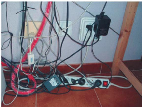
**Figura 20.** Incorrectas conexiones en enchufes múltiples.
