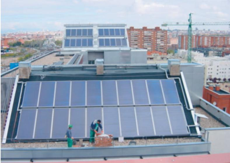
**Figura 11.** Ejemplos de integración solar con colector plano.
