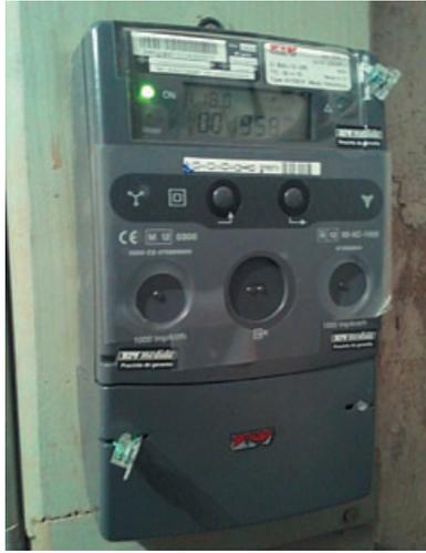
**Figura 7.** Contador electrónico trifásico.
