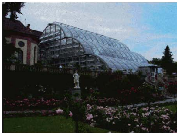
Vista del invernadero
