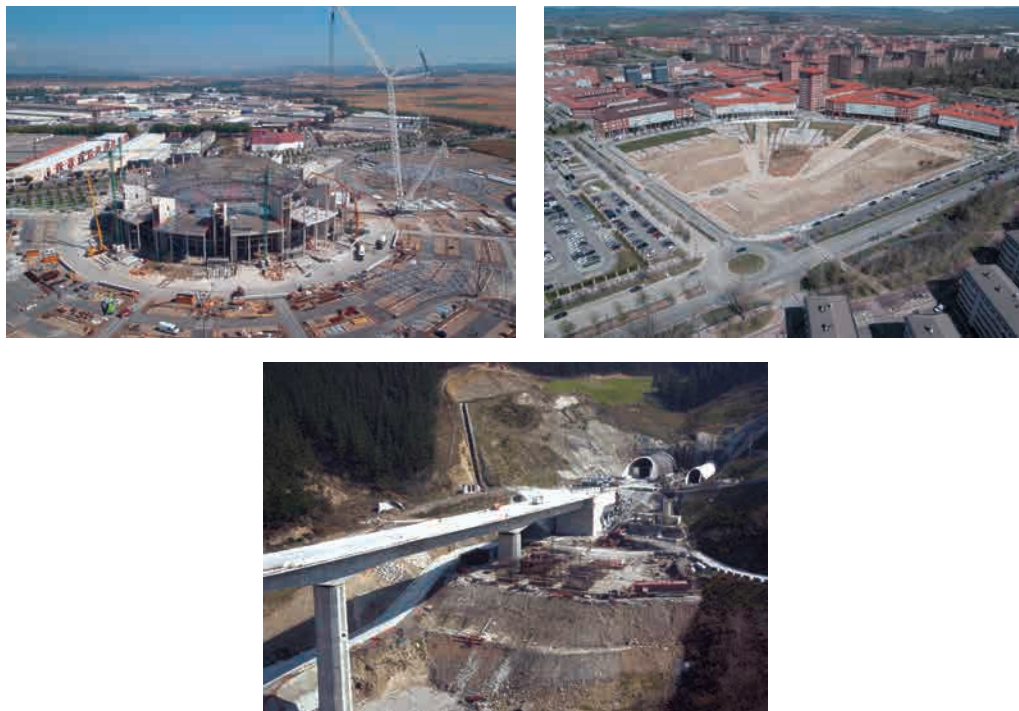
Figura 11.9. Imágenes de seguimiento visual de diferentes obras
