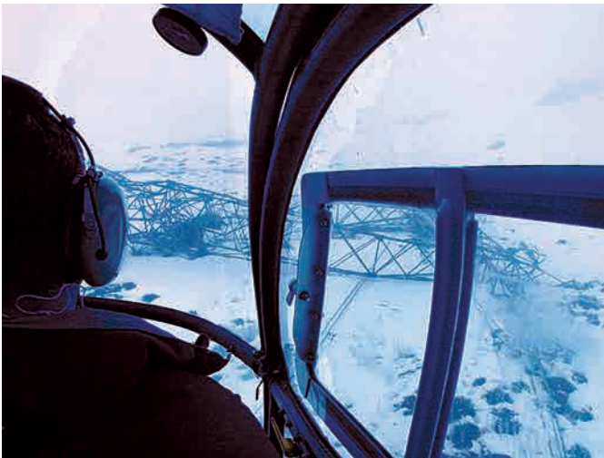
Figura 14.2. Vista desde un helicóptero de un apoyo caído en el suelo.
