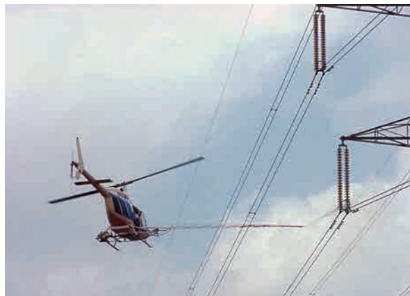
Figura 14.6. Limpieza de aisladores desde helicóptero.
