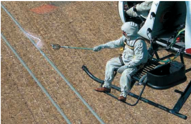
Figura 14.5. Trabajos en tensión desde helicóptero.
