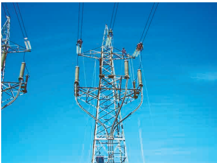
Figura 20.9. Trabajos de inspección en apoyo de 132 kV.
