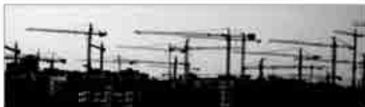
El territorio en el litoral se escribe con “T” de grúa, recordando las siluetas de estas estructuras que jalonan las costas y las áreas metropolitanas, fundamentalmente. Fotografía en Camas (Sevilla). Autor: Gonzalo Rodríguez.
